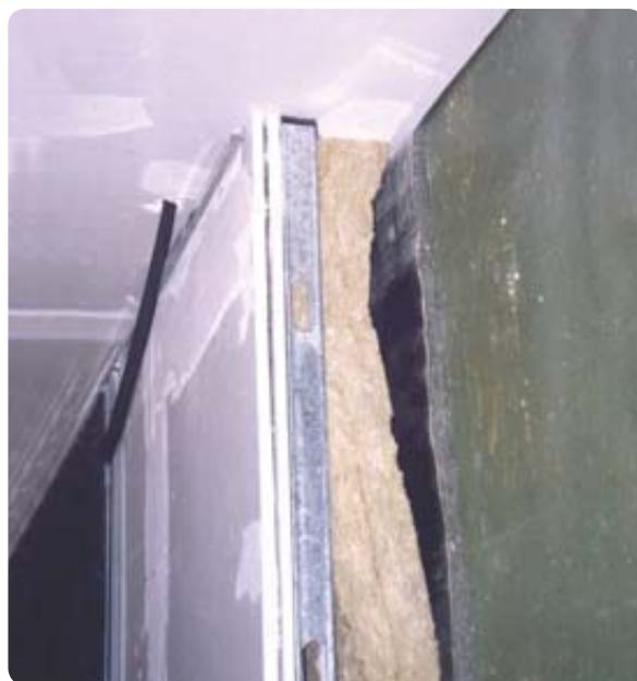
Trasdosado aislante con PKB-2.
