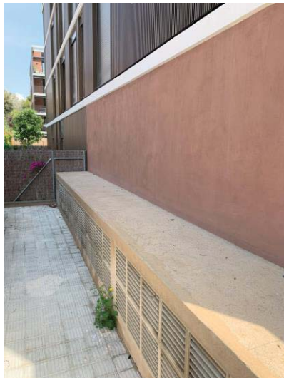
Fotografia de la façana principal, del tram de façana est, que dona a l'espai de la rampa d'accés a l'aparcament de la planta soterrani, i fotografies del tram de façana oest, que don a l'espai lliure de a parcel·la, i on es situa la bancada amb les reixes de ventilació del soterrani.
