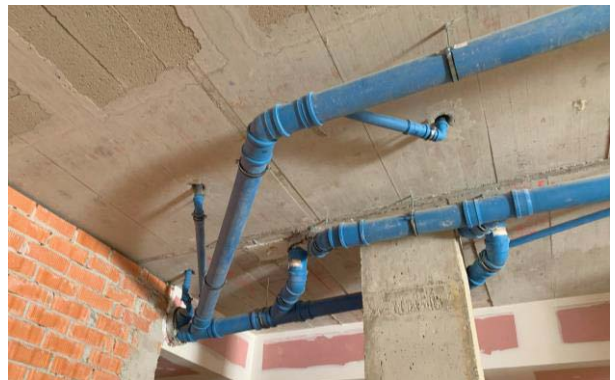
Fotografies de les instal.lacions de sanejament de les plantes superiors existents al sostre del local, i del tram de fals sostre també existent per on transcorren instal.lacions d'aigua i telecomunicacions dels habitatges.
