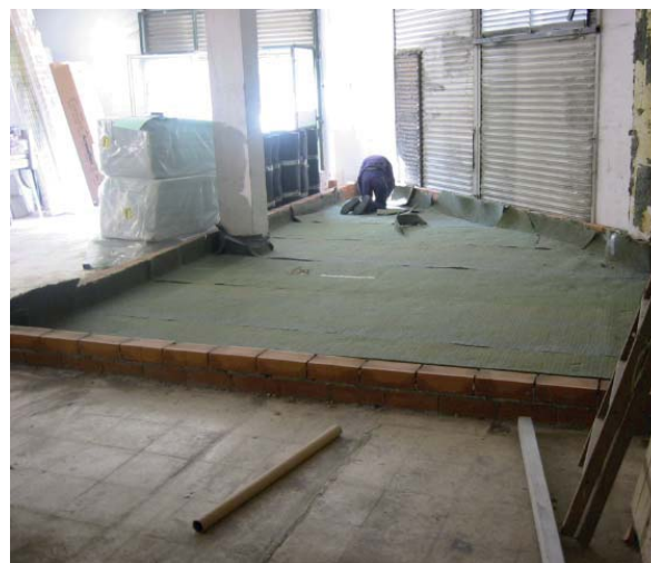
Montaje primera capa de A-1
