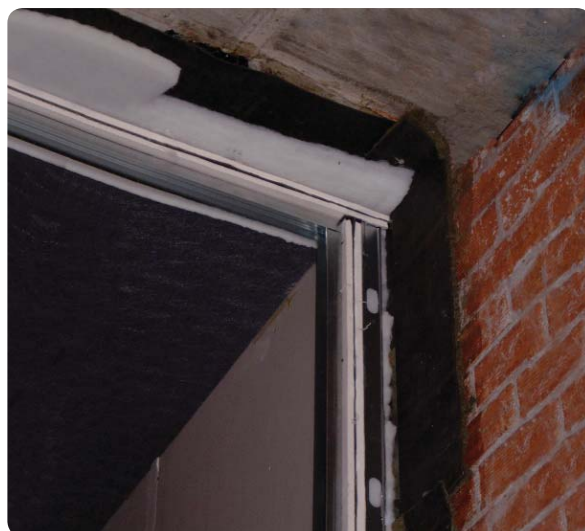
Trasdosado y techo aislante con LA.
