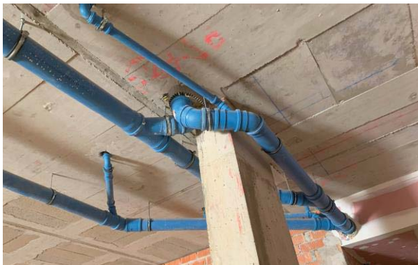
Fotografies de les instal.lacions de sanejament de les plantes superiors existents al sostre del local, i del tram de fals sostre també existent per on transcorren instal.lacions d'aigua i telecomunicacions dels habitatges.
