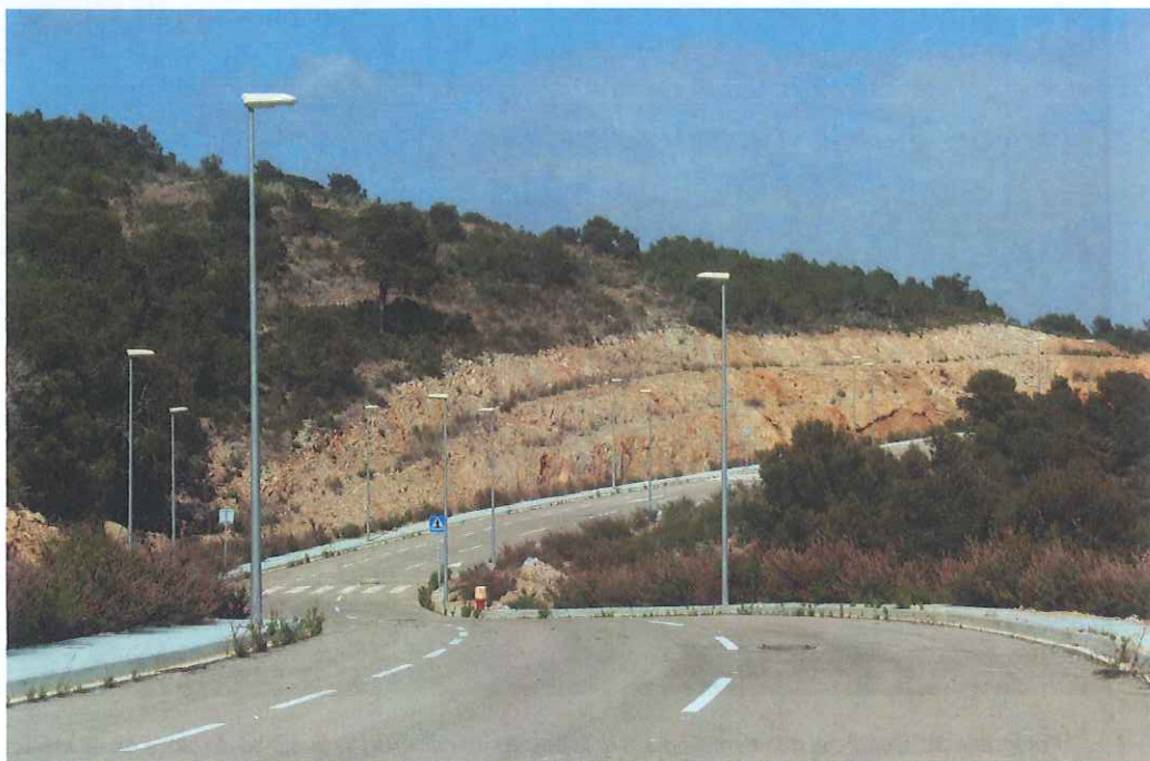
Fotografia 31. Vista des del carrer Girona dels talussos excavats en les calcàries cretàiques.
