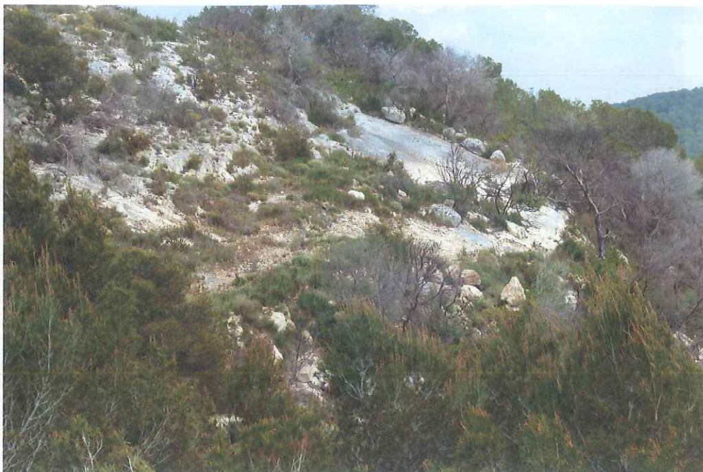
Fotografia 18. Vista dels blocs observats en el vessant dret de la urbanització, susceptibles de lliscar.
