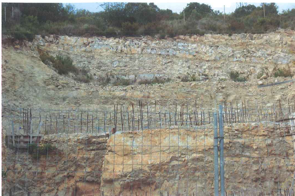
Fotografia 28. Vista d'una excavació on s'observen les calcàries cretàiques.
