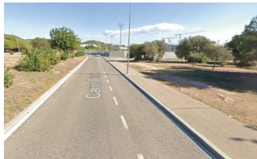
Figura núm. 25. Voreria Carrer Priorat Font: Google Street View
