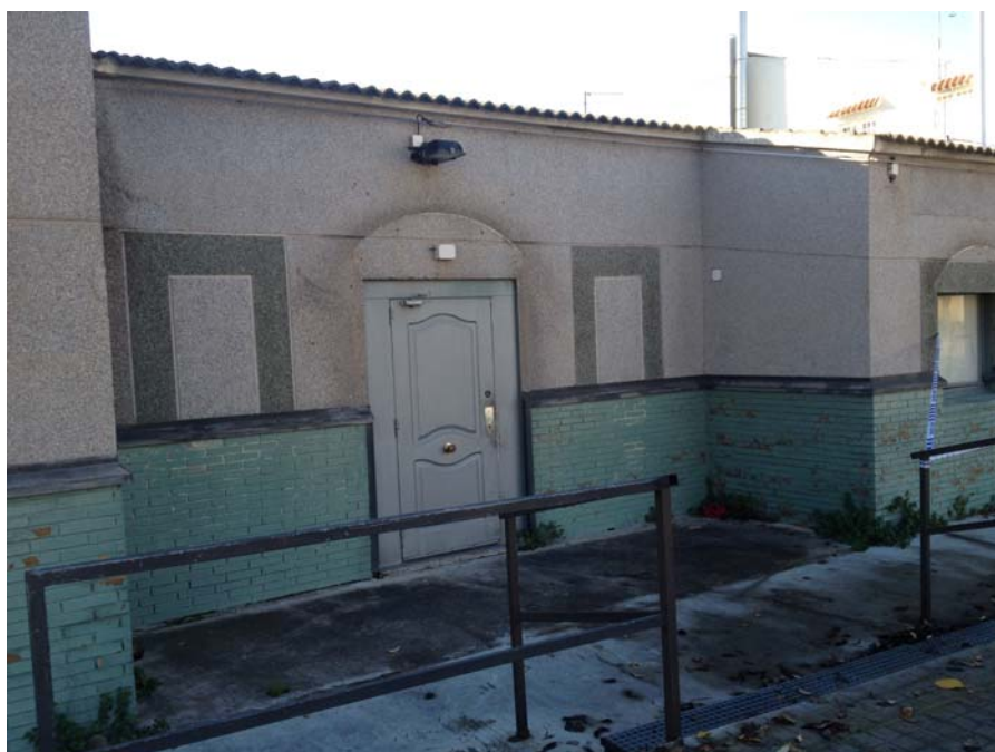
FOTO 3 – Detall entrada principal
