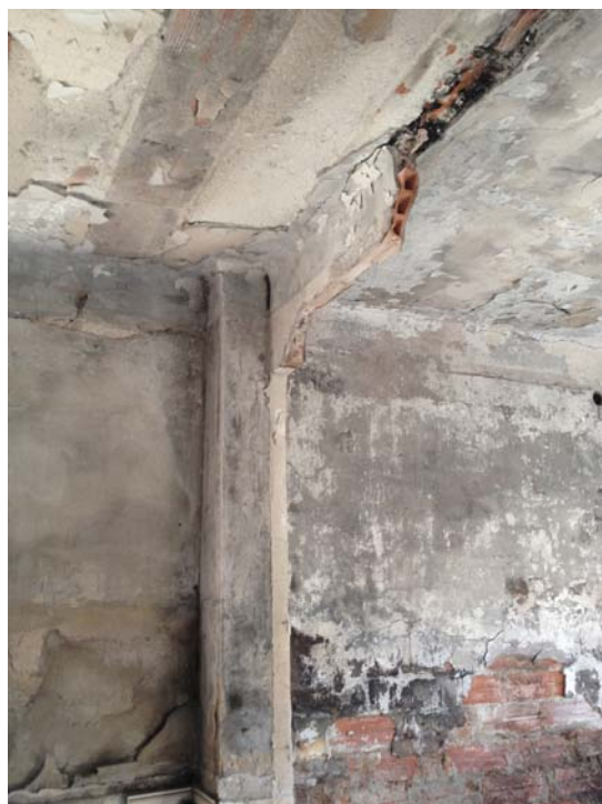
FOTO 5 – Detall interior estructura
